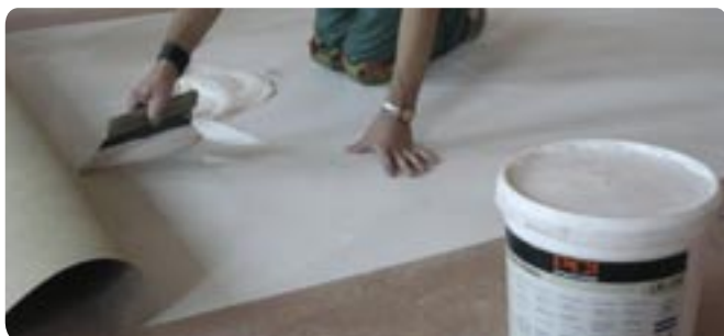
Lepení přírodního linolea na lepidlo LKL 334.
