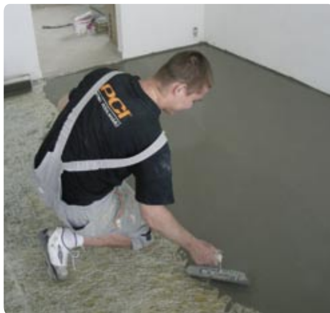
Realizace Armovacího systému PCI.
