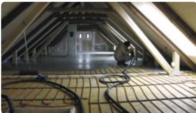
Zalévání podlahového vytápění na dřevěném podkladu.
