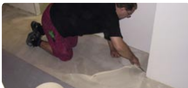
Lepení PVC podlahovin pomocí objektového lepidla OKL 300.
